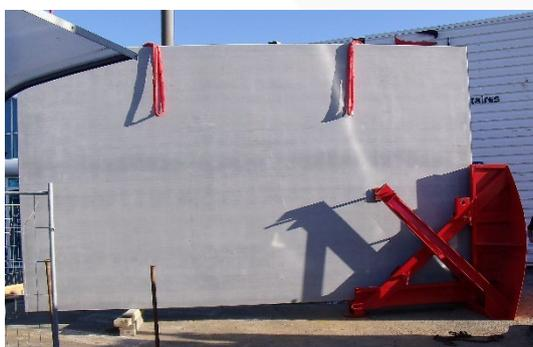
Disposer le prémur (en utilisant ses estropes) dans le retourneur. Utiliser un madrier d'environ 23 cm pour le calage de la tête du prémur. Le prémur sera placé bien au fond du retourneur. Si le prémur présente un décalage en pied entre ses 2 parois, alors il faudra compenser ce décalage avec un bastaing ou tout autre procédé.
